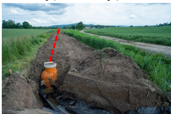
Abb. 27c: Kontrollschacht der parallel verlaufenden Drainage-Sammelleitung (rot gestrichelte Linie). (Bild: Christof Angst)
