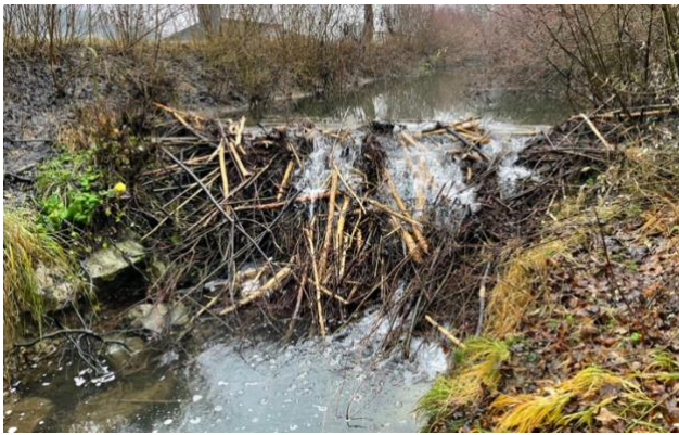
Abbildung 3-5: Der untere Biberdamm des Tegelbachs in seinem stark eingetieften Gerinne. Der Damm ist hoch und stabil gebaut. Bei Hochwasser wird er überflossen.
