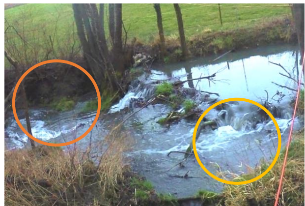
Abbildung 4-15: Im Bereich des Biberdammes bleibt die Pegeldifferenz vergleichbar hoch, auch während Hochwasserereignissen (oranger Kreis). Im Bereich der Aue ist die Pegeldifferenz geringer (gelber Kreis). Bild: Schwarzbach; Bild mit 149°-Ultraweitwinkel-Objektiv (Distanzen täuschen).
