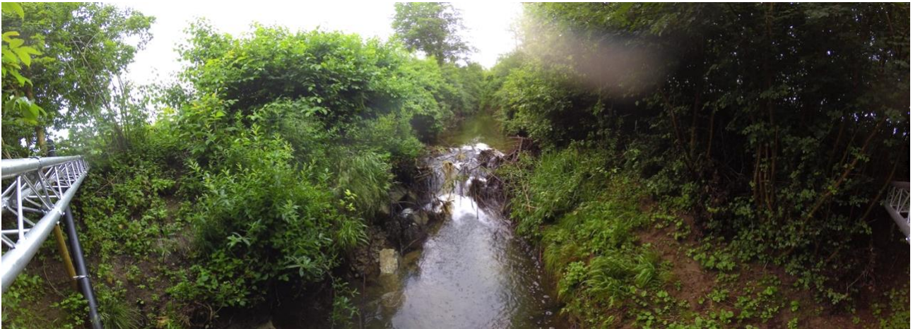
Abbildung 4-10: Unterer Biberdamm am Tegelbach bei Niederwasserabfluss am 07.07.2021 bei eine Pegeldifferenz von 1.2 m. Bild mit 149°-Ultraweitwinkel-Objektiv (Distanzen und Grössenverhältnisse täuschen).
