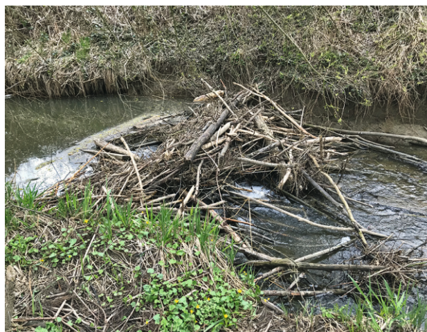
Abb. 7: Ein kleiner Biberdamm in der Fließstrecke des Abschnittes E. Derartige „Bauwerke“ waren im Jahr 2022 regelmäßig in diesem Abschnitt zu finden (Foto: A. Schwarzer).
